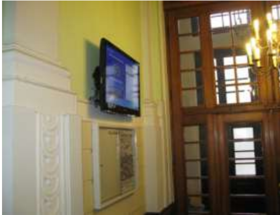
Slika 3. – Izvedba EE panela na objektu Ministarstva financija
