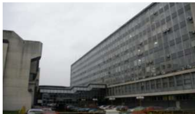
Slika 15.- Južni objekt MINGORP-a
