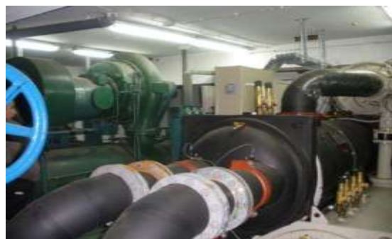
Slika 17.- Zamjena rashladnog agregata - ušteda oko 25.000 kn/godišnje.
