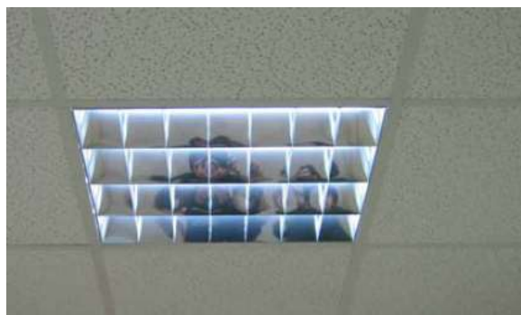
Slika 18.- Zamjena rasvjete na objektu Jug - ušteda oko 7.500 kn/godišnje.
