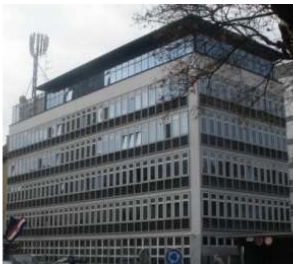
Slika 50.- Zgrada MVEP-a, Petretićev trg 2
